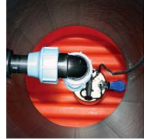
PW Easy -pumppaamo ylhäältä sisälle katsottuna.
