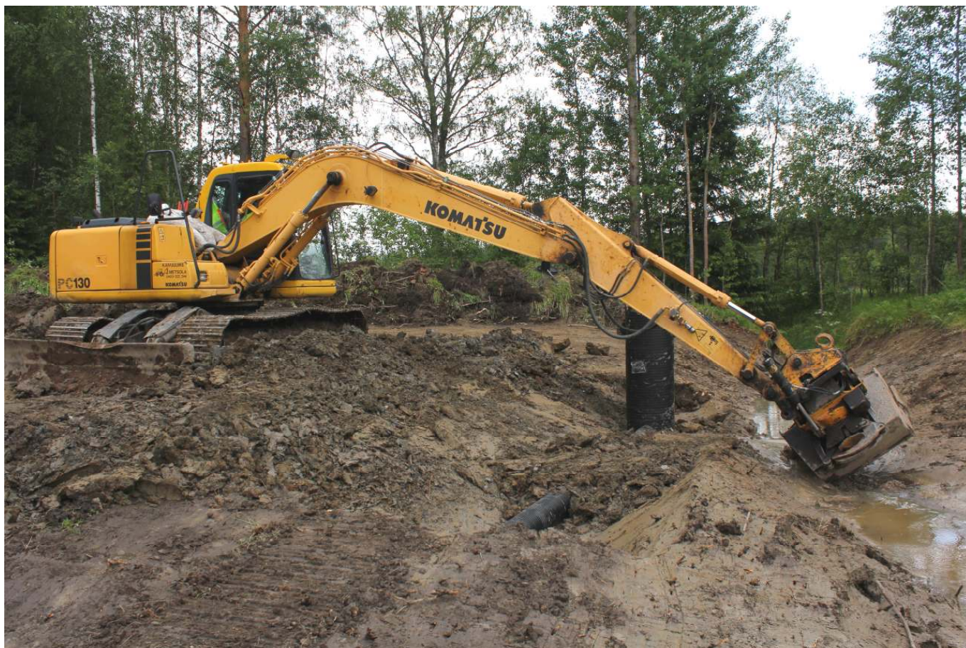
Kuva 11. Putkien ja kaivon ympärityöissä kannattaa käyttää notkeampaa ja hyvin muotoutuvaa savea. Jäykällä savimailla täyttömaiden muotoiltavuutta voidaan parantaa veden avulla.
