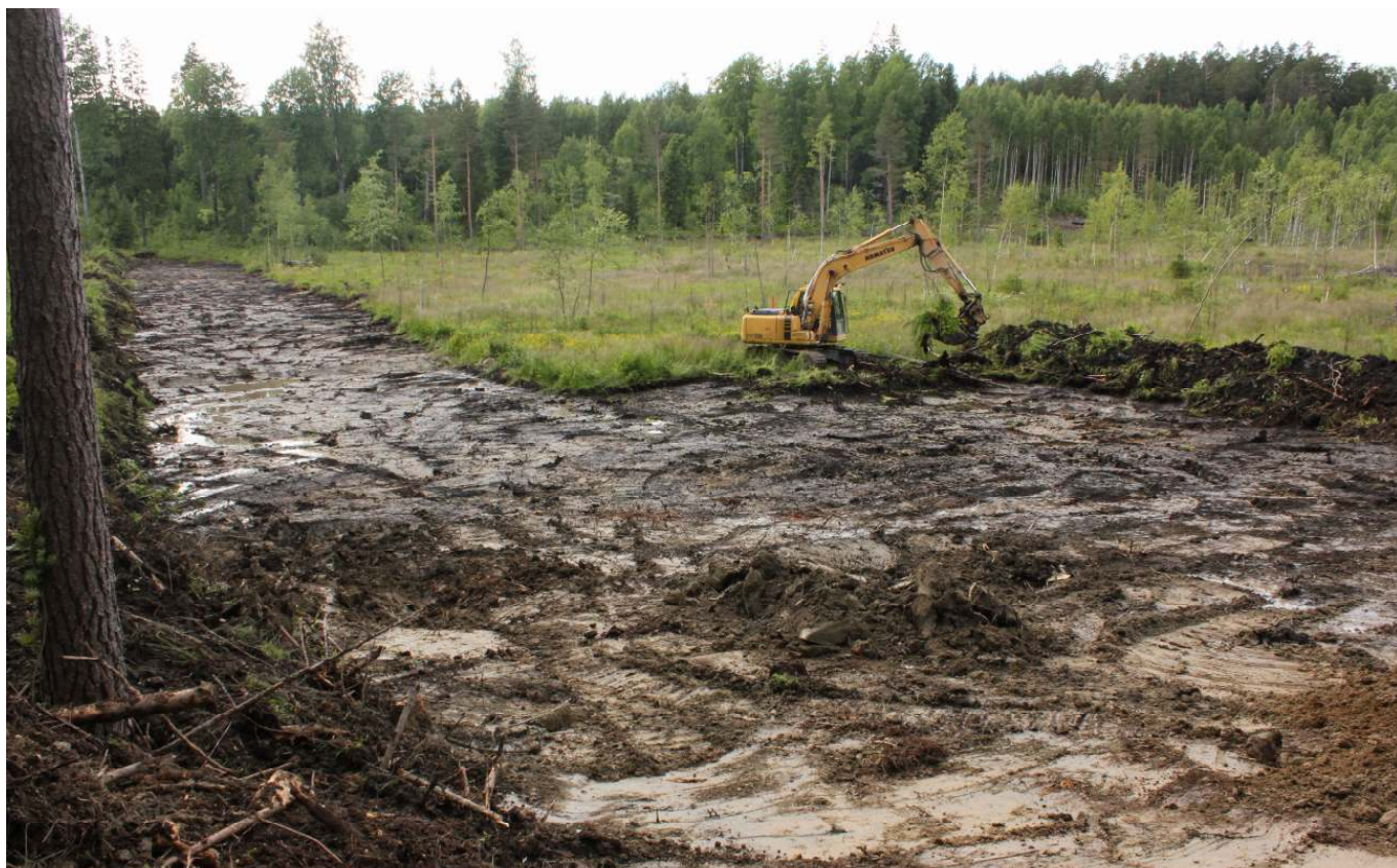
Kuva 6. Patorakennustyöt aloitetaan aina pintamaiden kuorimisella. Huolellisesti toteutettu pintamaiden kuorinta helpottaa työmaasuunnittelua ja seuraavien työvaiheiden läpivientiä!
