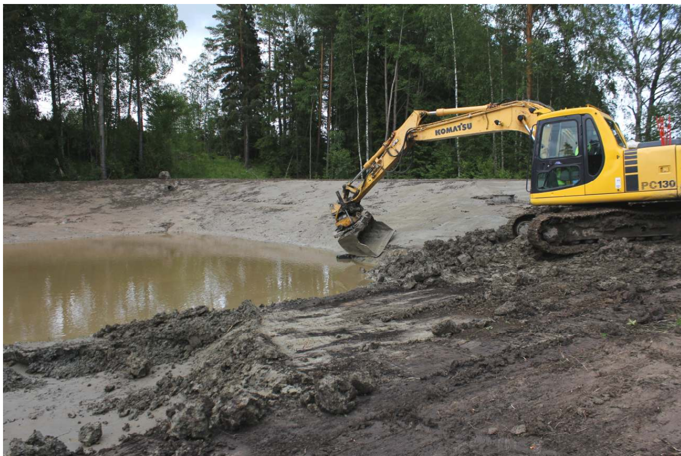
Kuva 16. Tuloputken kaulus tiivistetään huolellisesti kaivinkoneella ja viimeistellään tarvittaessa lapiotyönä.
