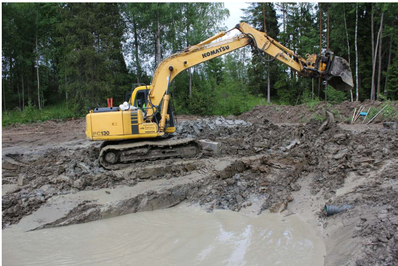
Kuva 15. Patokaivon tuloputken suulle kaivetaan syvännä kiintoaineen pidättämiseksi.
