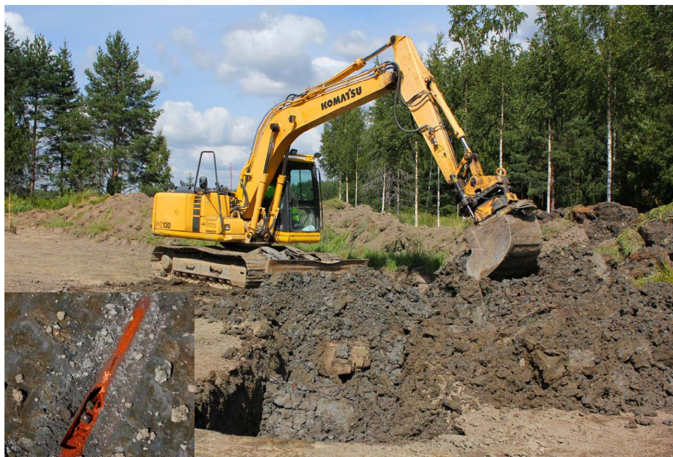
Kuva 7. Salaojaputkistot ja muut kohteelta löytyvät vanhat vedenjohtamisrakenteet on syytä rikkoa ennen kaivon asennusta ja patopenkereen rakentamista.
