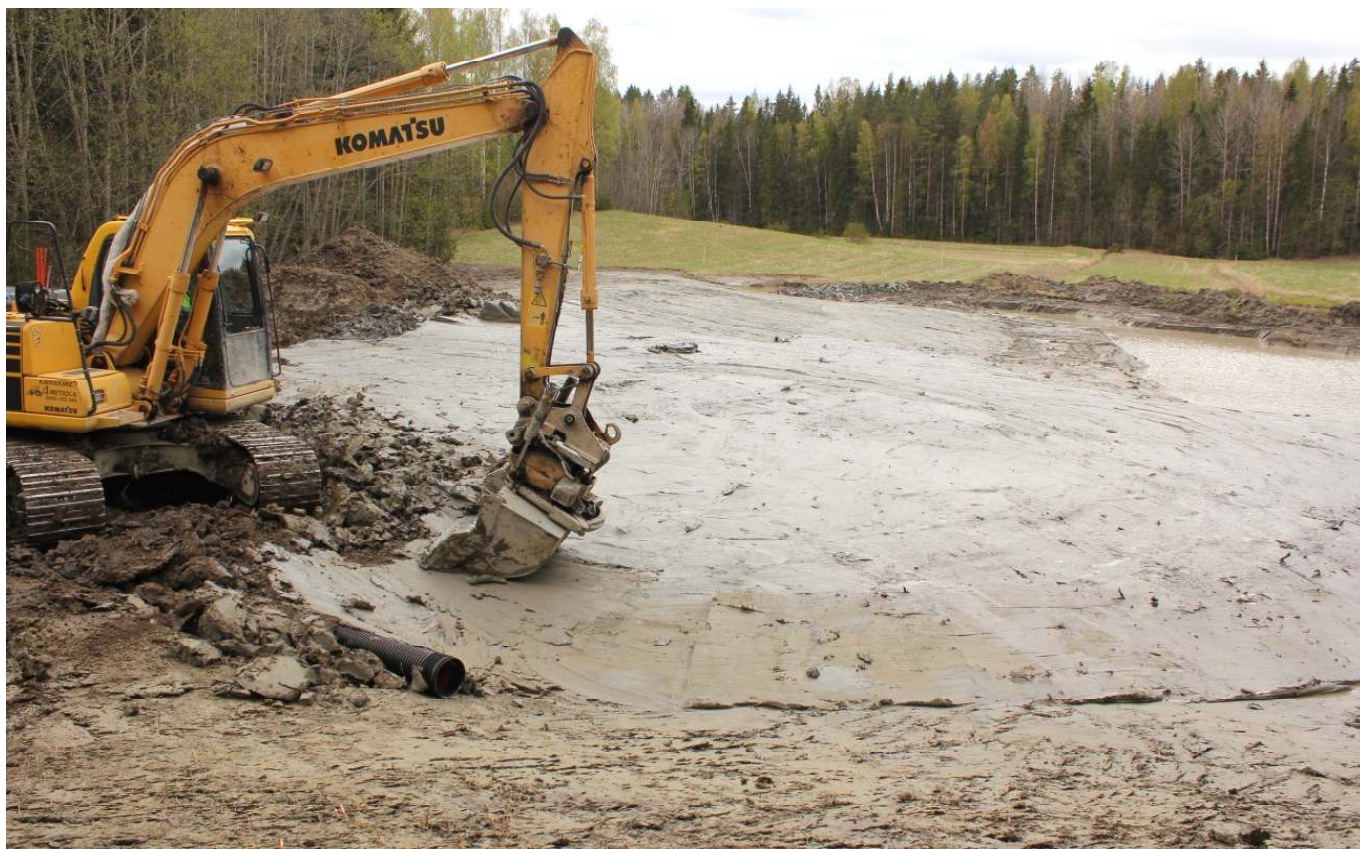
Kuva 19. Säättösalaajakaivon rinnalle kosteikon suunnitellun maksimipadotuskorkeuden tasolle asennettu ylijuoksutusputki turvaa kosteikon hallitun vedenjohtamisen myös patokaivon mahdollisessa tukkiutumistilanteessa.
