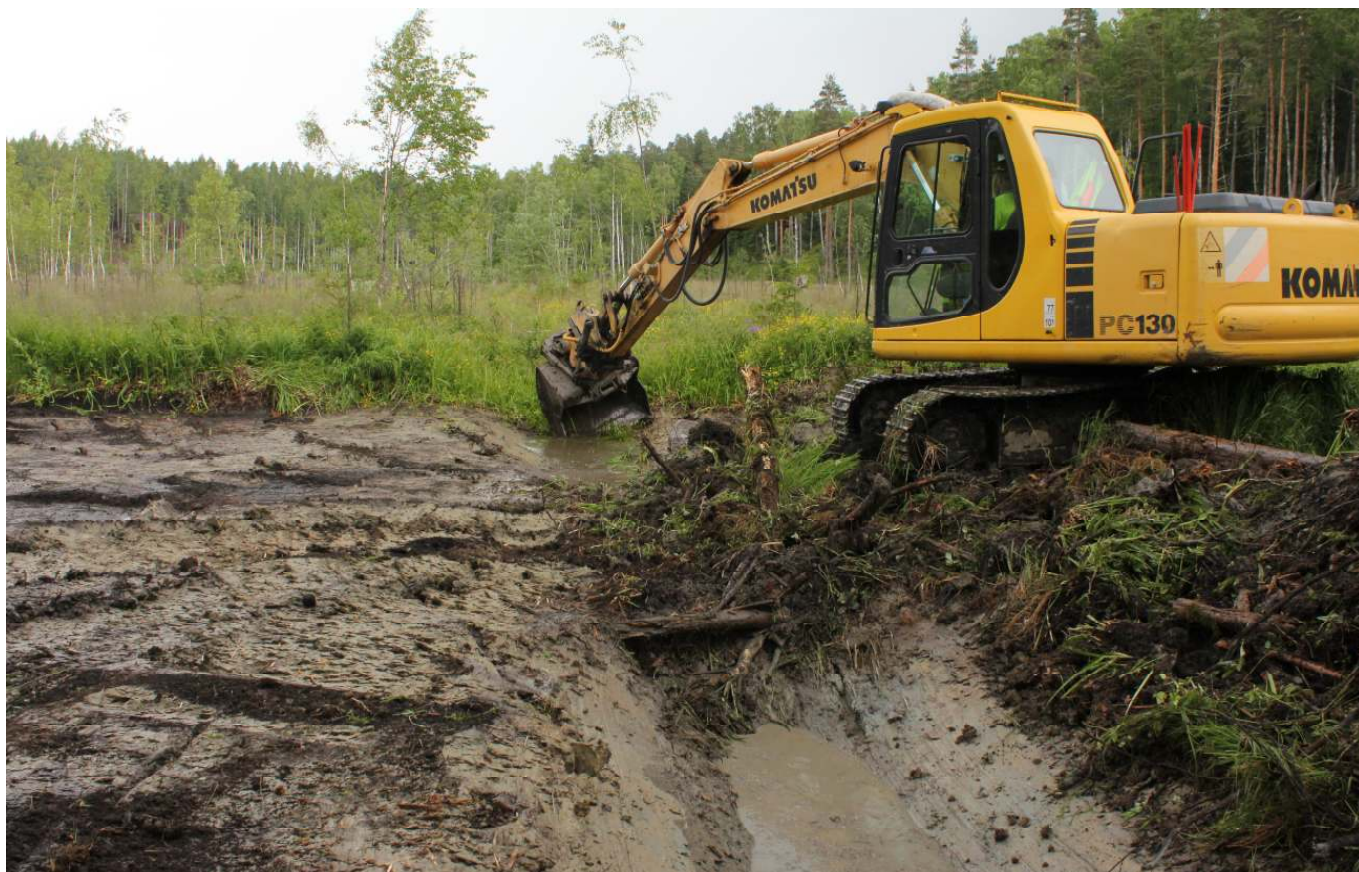
Kuva 8. Valtaojat ja muut vesiä kosteikkoalueelta poisjohtavat pienemmät ojauomat puhdistetaan lietteestä patorakennuspaikan alueella ennen patokaivon asentamista.
