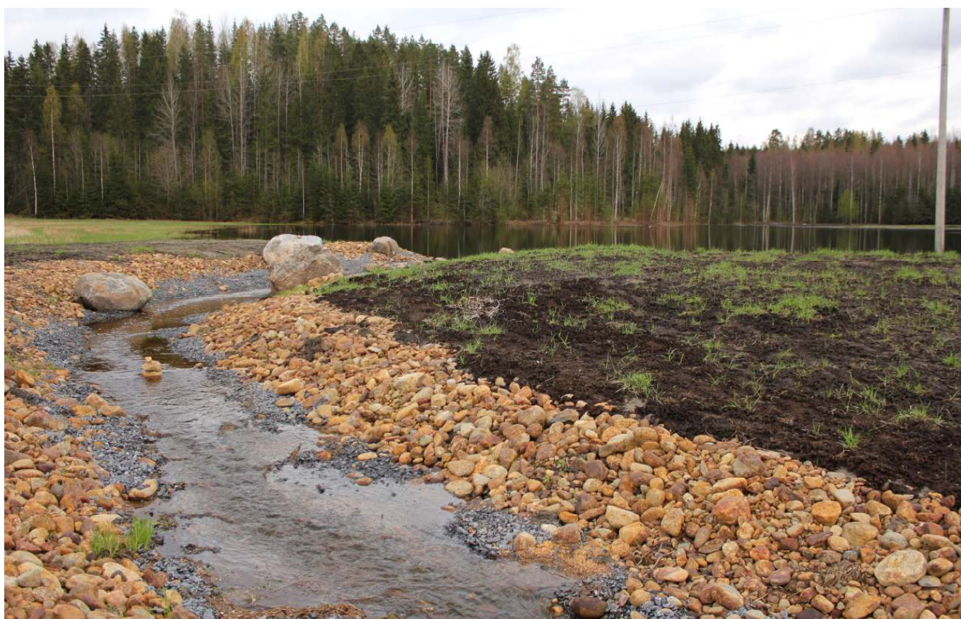
Kuva 20. Suurempien valuma-alueiden kohteilla padon jatkeeksi rakennettu luonnonmukainen virtausuoma turvaa vesien hallitun johtamisen patokaivon mahdollisissa tukkeutumistilanteissa. Mutkittelevaksi rakennettu kivetty virtausuoma ja soliseva vesielementti lisäävät samalla alueen viihtyisyyttä ja maisemallista vaihtelua.
