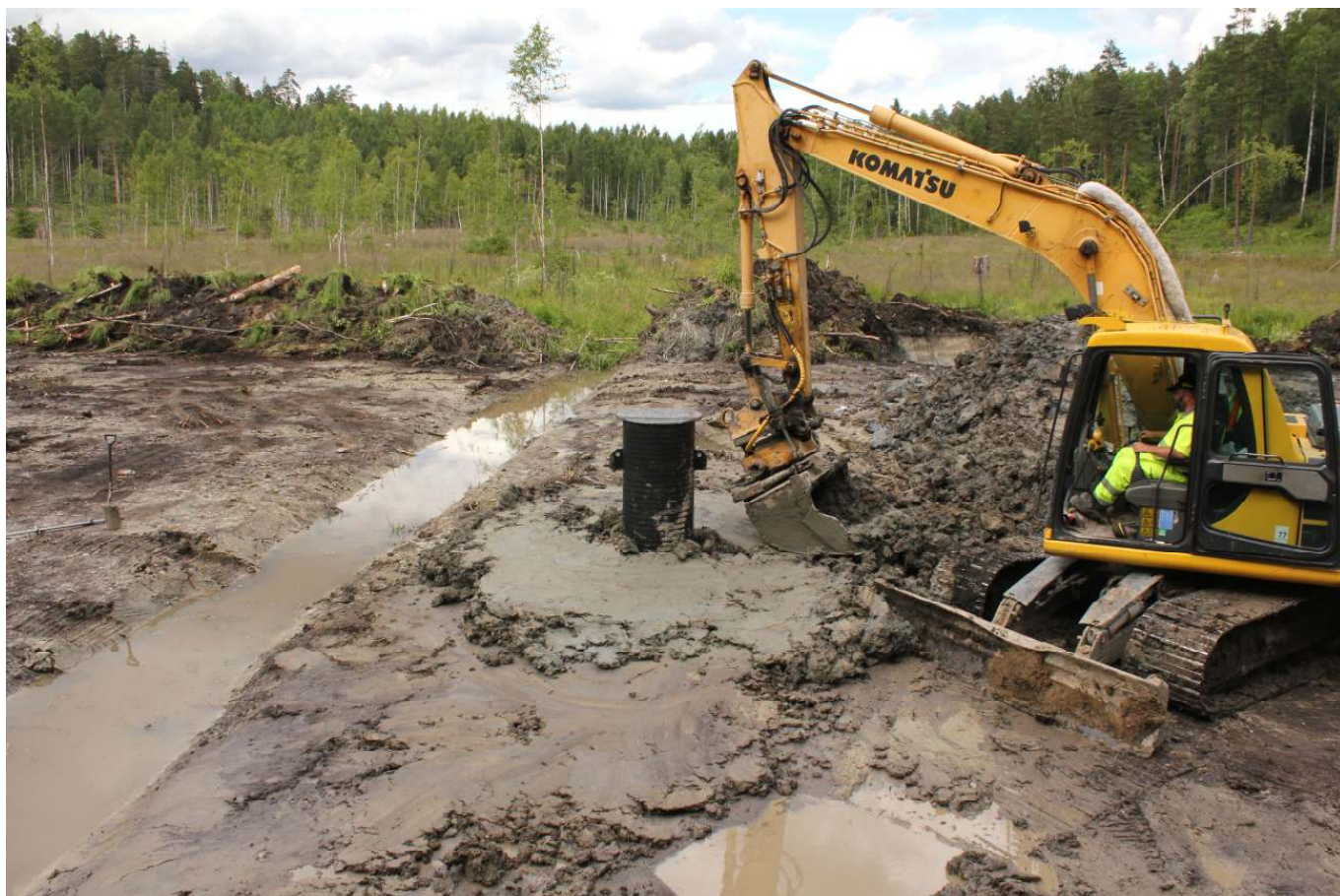
Kuva 14. Patokaivon maatyttö toteutetaan tasaisesti kaivoa kiertäen. Rototiltti kaivinkoneen lisävarusteena helpottaa huomattavasti kaivon ympäritäyttöä.
