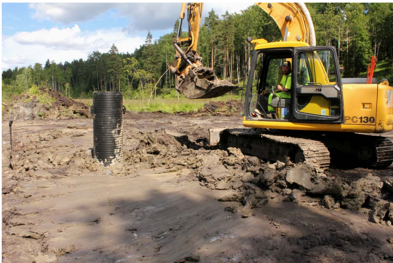
Kuva 12. Rumpuputkien maatyttö kannattaa tehdä huolellisesti. Kaivinkoneen kauhalla varovasti painamalla ja liippaamalla elastinen savi tiivistyy tiukasti rumpuputkien ympärille.
